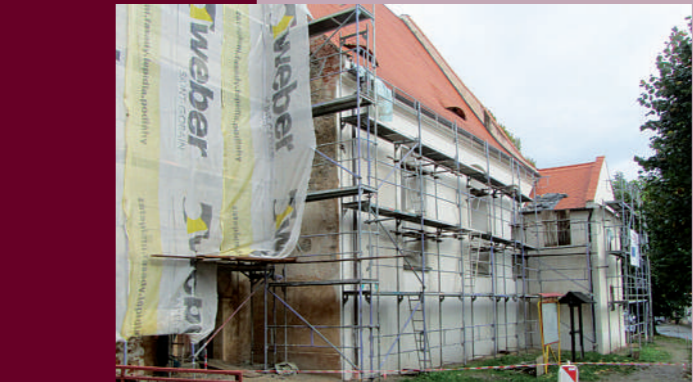
▲ Pozdně gotický krov lodi. Obnova exteriéru.
